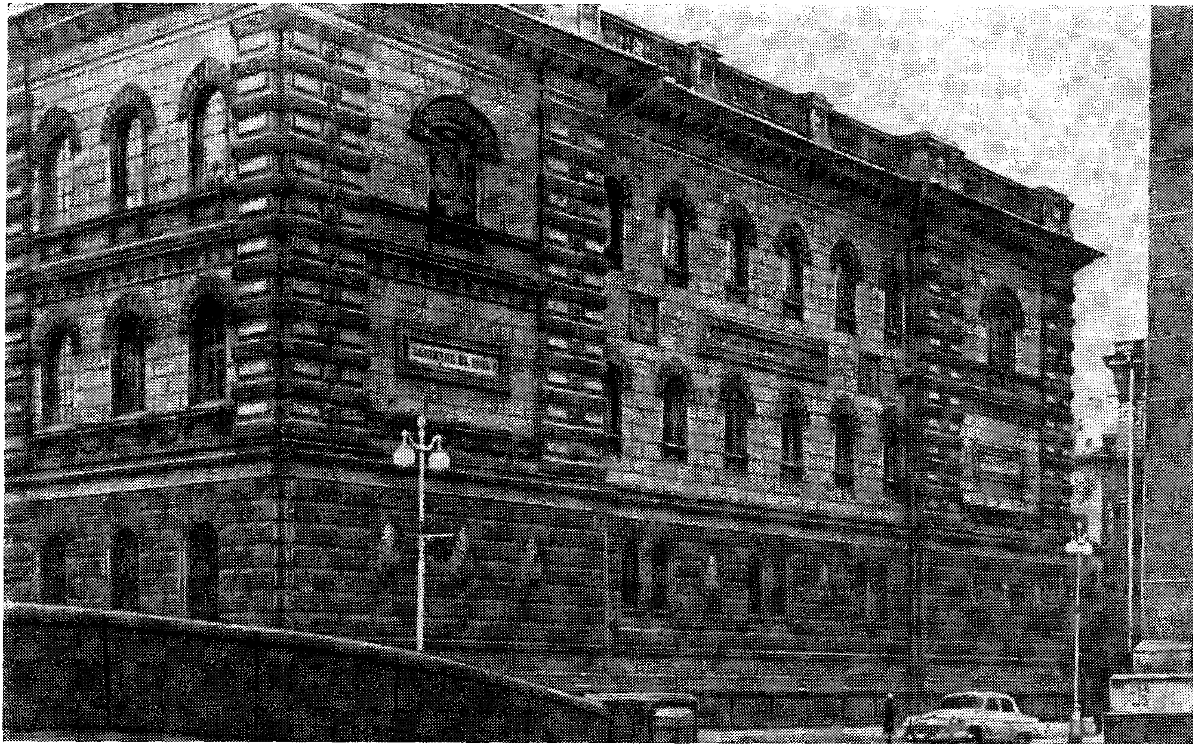
Рис. 1. Фасад главного здания Центрального государственного архива ВМФ СССР (ул. Халтурина, 36).
